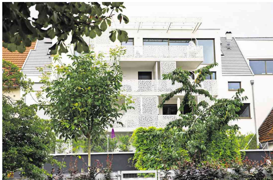
Den Blickfang an der Fassade übernehmen die gelochten Balkonabdeckungen.
