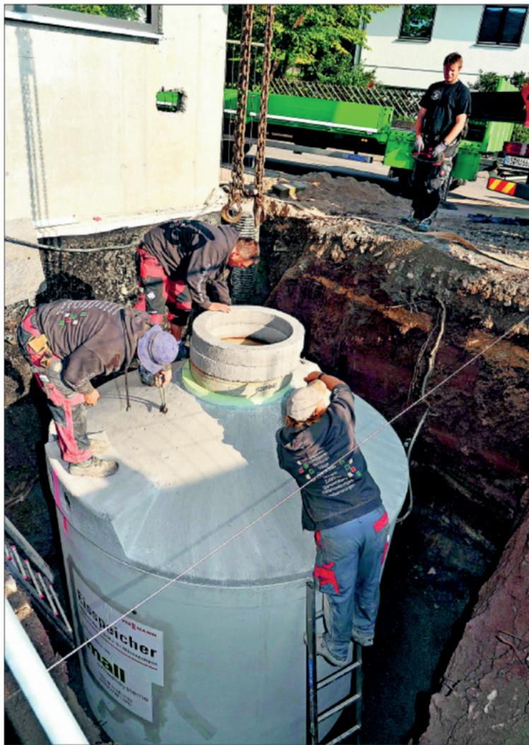
Der Eisspeicher wird mit zehn Kubikmetern Wasser gefüllt
